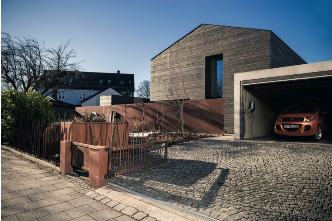
Bild 2: Ladeeinrichtung für Elektrofahrzeuge auf einem privaten Grundstück
